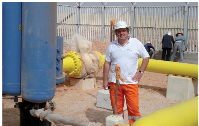
Estación de seccionamiento del gasoducto
