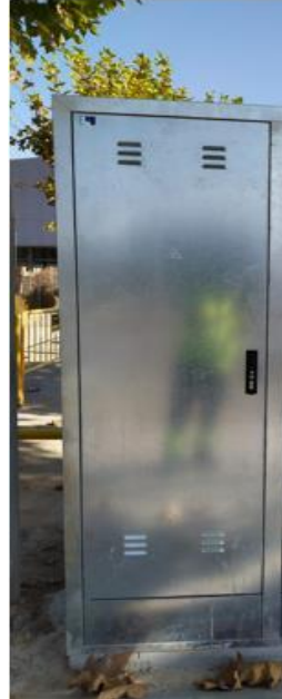
Vista exterior puerta
